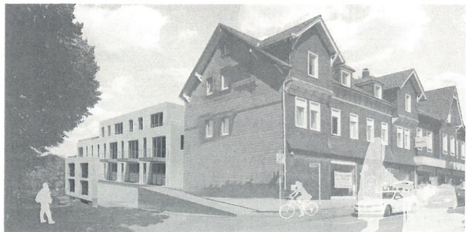
Direkt neben dem Zentrum Emmaus, Hauptstraße 43, auf einem 1.500 Quadratmeter großen Grundstück wird das alte Supermarkt-Gebäude teilweise zurückgebaut und auf dem erhaltenswerten massiven Sockel neu aufgebaut, das Schieferhaus direkt an der Hauptstraße wird saniert.
